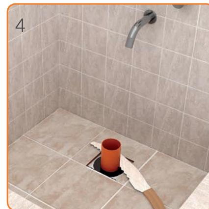
4. Se corta tubo desagüe ducha saliente a la altura requerida.
